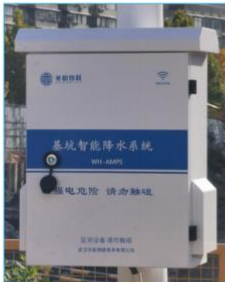
基坑智能降水
