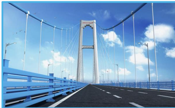
荆州-李埠长江公铁大桥-桥梁
