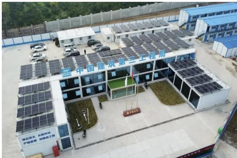
临建“光储直柔”一体化技术应用
