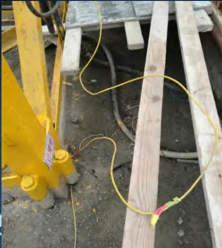
32) 存在问题：分配电箱PE接地线接在塔吊**标准节螺栓上**不符合：**JGJ46-2005 第5.3.4条**：不得采用铝导体做接地体或地下接地线。垂直接地体宜采用角钢、钢管或光面圆钢，不得采用螺纹钢。接地可利用自然接地体，但应保证其电气连接和热稳定。
