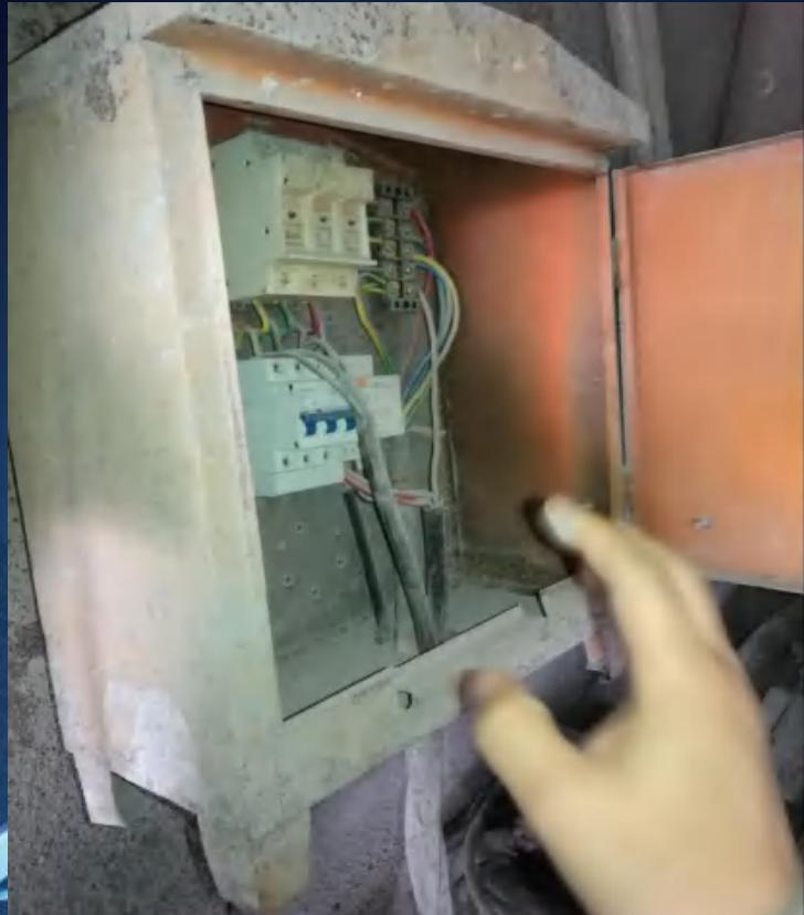
27) 存在问题：开关箱接线排无防护罩，电源线从漏电保护器上端接出
