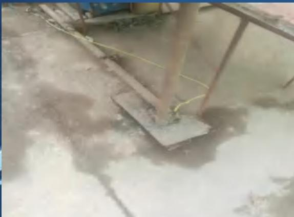
28) 存在问题：钢筋加工机械接地接在钢管扣件上
