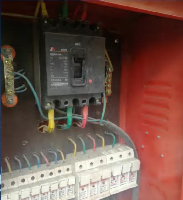
34 ) 存在问题：漏电断路器下直接接出电源线
